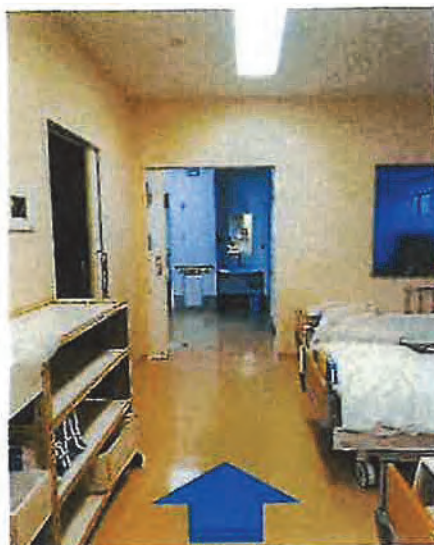
食堂側出入口
